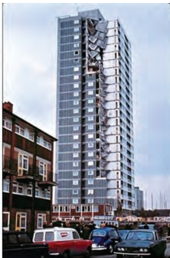
Рисунок 1. Последствия взрыва газа «Ronan Point»
