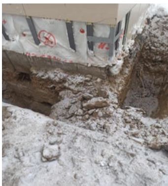
Рисунок – 1 - разработанный шурф под наружную продольную и поперечную стену
