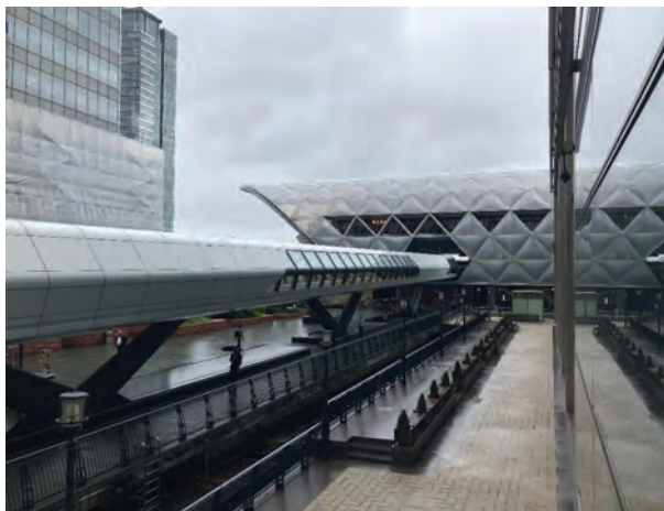
Рис. 1 – «Сад на крыше» на территории Канэри - Уорф (вид снаружи)
