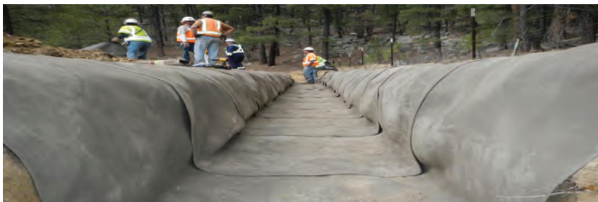
Рисунок 2. Гибкий бетон Concrete Canvas
