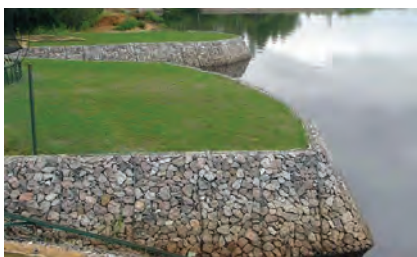
Рисунок 1. Общий вид барьерного защитного ограждения в виде габионов для защиты железнодорожных путей Источник: https:// geoinfo.ru / product
