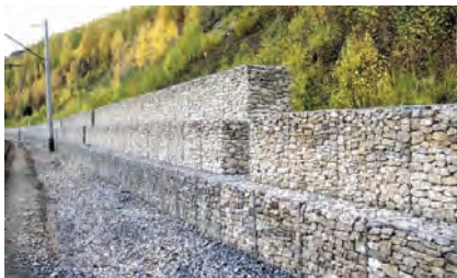
Рисунок 2. Общий вид барьерного защитного ограждения в виде габионов для защиты берегов водоемов Источник: https:// dizlandshafta.ru
