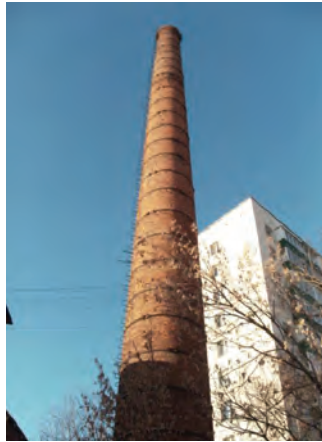
Рисунок 1 – Общий вид кирпичной дымовой трубы
