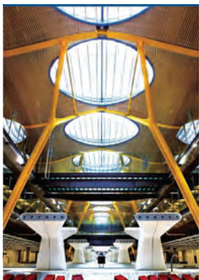
Рисунок 2 – Сопла TROX в зоне для регистрации идеально вписываются в архитектуру Мадрид, Испания
