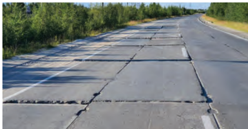
Рис. 1. Дорожное покрытие из железобетонных плит
