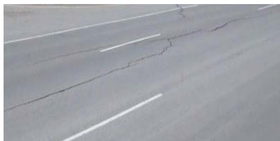
Рис. 3 Силовые трещины
