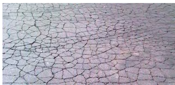
Рис. 4 Технологические трещины
