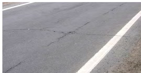
Рис. 2 Температурные трещины
