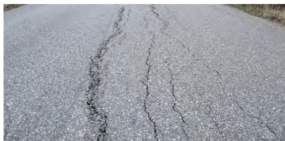
Рис. 5 Усталостные трещины
