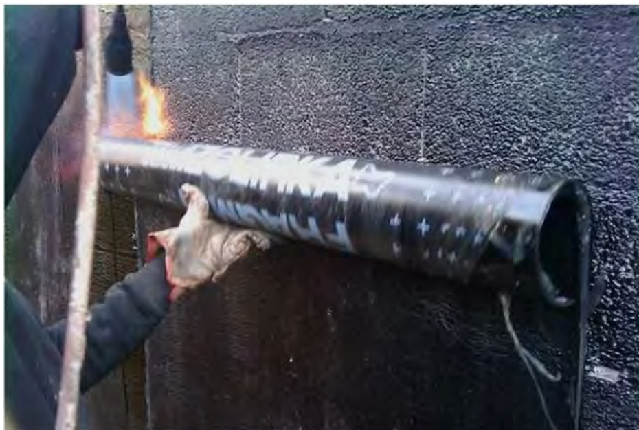
Рисунок 2 – Наплавляемая гидроизоляция
