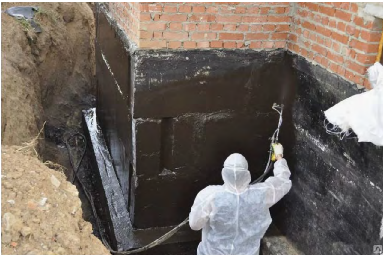
Рисунок 4 – Нанесение обмазочного гидроизоляционного материала на тело фундамента
