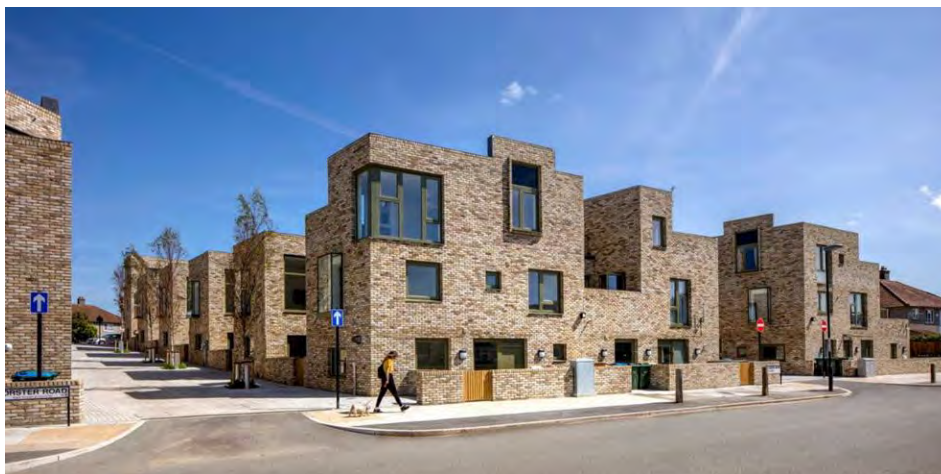
Рисунок 7 – Проект кирпичного таунхауса с террасами в Лондоне от бюро Peter Barber Architects Визуализация [10]
