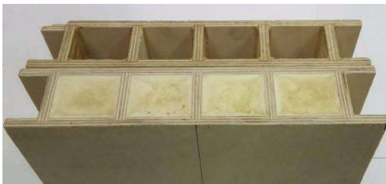
Рисунок 3 – Поперечное сечение ребристой сэндвич панели с пенопластовым сердечником
