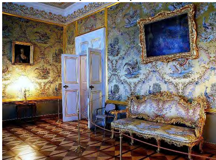
Рисунок 3 – Обшивка стен тканью
